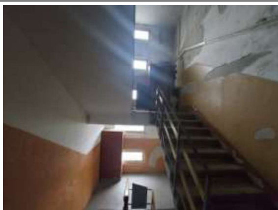
2.stāva kāpņu telpa
