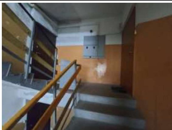
2.stāva kāpņu telpa
